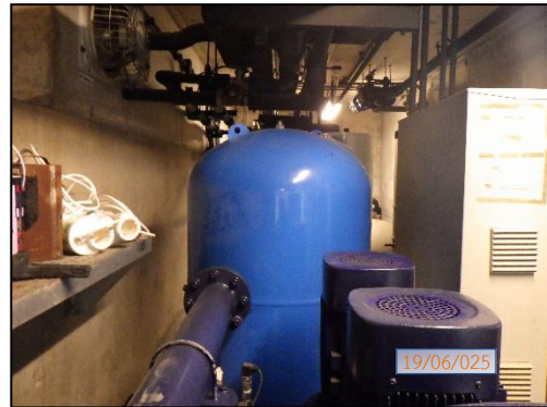
รูปที่ 2-20 ระบบสูบน้ำในอาคาร ซึ่งทำหน้าที่สูบน้ำโดย โดยไม่ดึงน้ำเข้ามาจากท่อประปาโดยตรง และควบคุมการจ่ายน้ำด้วยระบบตั้งเวลา
