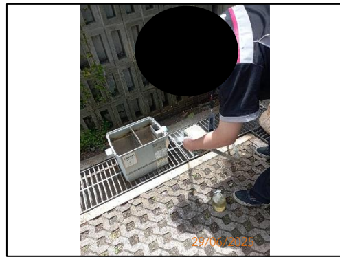
รูปที่ 2-16 จัดให้มีพนักงานตัก และล้างถังตกตะกอน (2)
