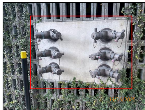
รูปที่ 2-70 หัวรับน้ำดับเพลิงภายนอกอาคาร (Fire Department Connector: FDC)
