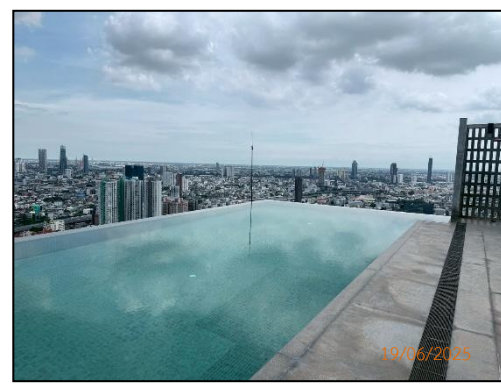
รูปที่ 2-28 โครงสร้างสระว่ายน้ำเป็นคอนกรีตเสริมเหล็ก พื้นสระว่ายน้ำทำด้วยวัสดุแข็งแรง อยู่ในสภาพดี
