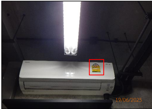
รูปที่ 2-55 ระบบปรับอากาศที่ติดตั้งภายในอาคาร ต้องมีค่าสัมประสิทธิ์สมรรถนะขั้นต่ำ ค่าประสิทธิภาพการให้ความเย็น และค่าพลังงานไฟฟ้าต่อตันความเย็นเป็นไปตามที่รัฐมนตรีประกาศกำหนด (ฉลากเบอร์ 5)
